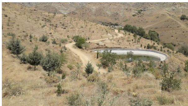
ث) تراس - نهال کاری به همراه احداث مخزن ذخیره آب با فناوری ژئوممبران
